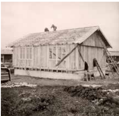
Aufgestellt in einem Tag: Montage eines Hauses der Siedlung «Im Landauer» (1943-1947).
