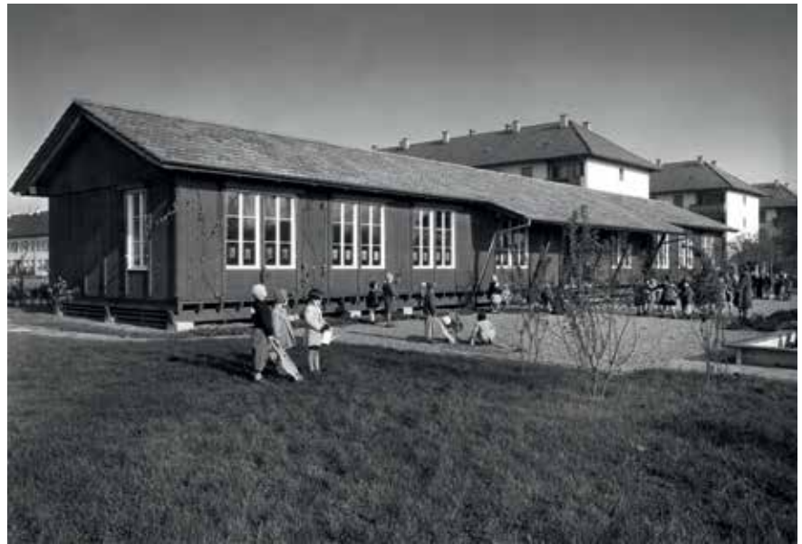
Sinnfälliger Werbespruch der Firma Nielsen-Bohny; von Kantonsbaumeister Julius Maurizio geplante und 1949 errichtete Kindergärten am Oberen Batterieweg 11 (links, Foto 1950) und an der Wittlingerstrasse 176 (rechts, Foto 1949).
